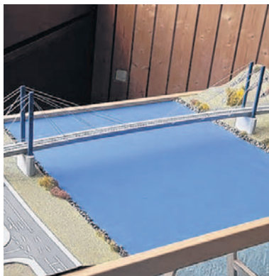
Ein Modell der Brücke (links) zeigt, wie sich die von 40 Meter hohen Pylonen gestützte Querung bei Zwingenberg über den Neckar spannen wird. Der Bau hat begonnen und soll in zwei Jahren abgeschlossen sein. BILDER: KRUG
