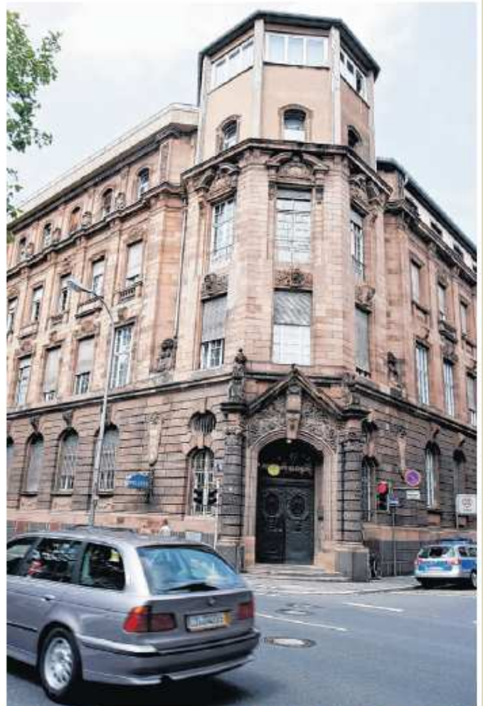
Sanierung dringend nötig: das 1903 errichtete Gebäude des Polizeipräsidiums im Quadrat L 6.
