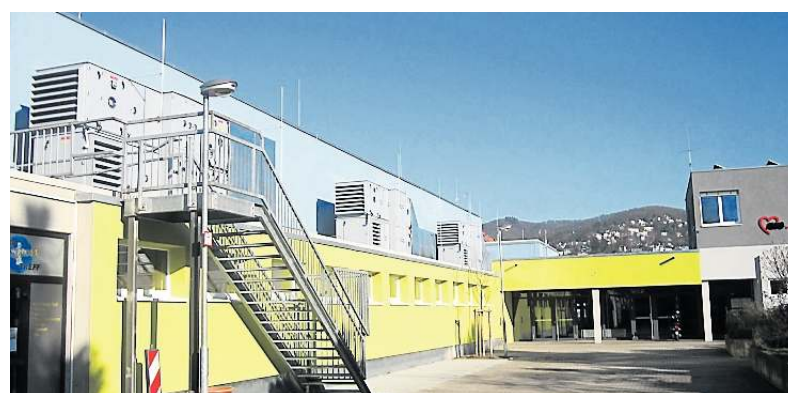
Die Schriesheimer mögens farbig; giftgrün fällt der Anstrich der Außenwand der Mehrzweckhalle aus. BILD: GROSS
